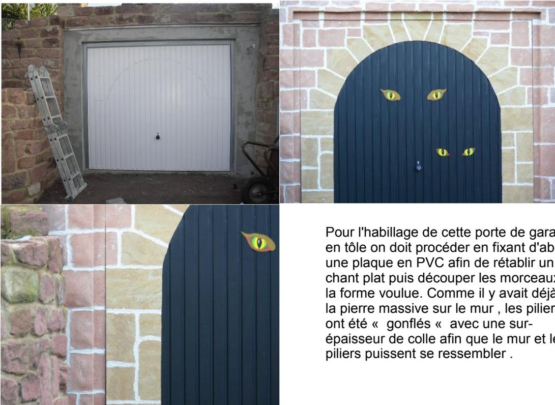
Pour l'habillage de cette porte de garage en tôle on doit procéder en fixant d'abord une plaque en PVC afin de rétablir un chant plat puis découper les morceaux à la forme voulue. Comme il y avait déjà de la pierre massive sur le mur , les piliers ont été « gonflés » avec une sur-épaisseur de colle afin que le mur et les piliers puissent se ressembler .
